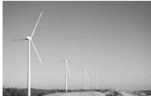
御前崎風力発電所
