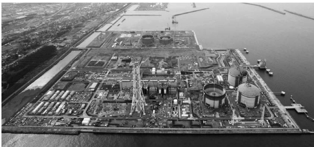
上越火力発電所建設状況(平成22年12月時点)
