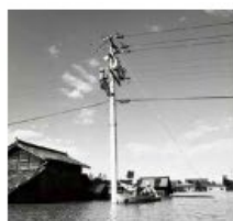
伊勢湾台風での配電線の復旧 工事(1959年)
