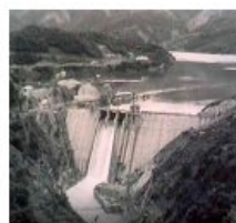
井川水力発電所(1957年)
