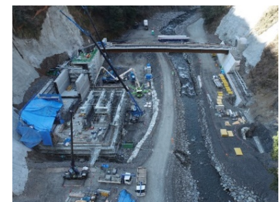
安倍川水力発電所 (建設状況)
