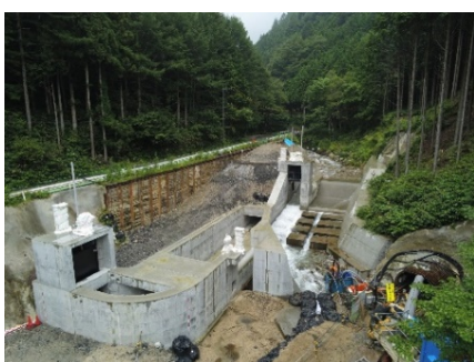
清内路水力発電所 (建設状況)
