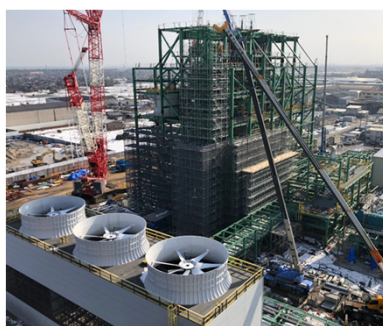
米子バイオマス発電所 (建設状況)
