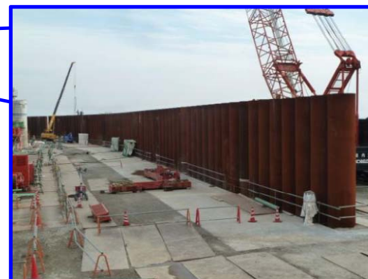
鋼管矢板の建込後の様子 今後、鉄筋コンクリート被覆の 施工を行う
