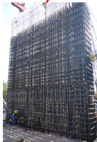
鉄筋建て込み作業
