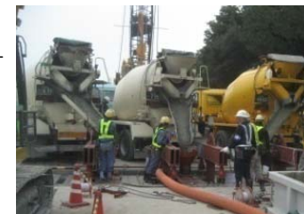
コンクリート打設作業
