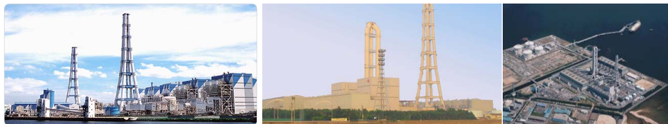
供給力のベースを支える電源やLNG基地 (写真は左から、碧南火力発電所、川越火力発電所・LNG基地)
