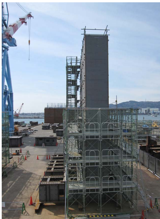
工場で仮組みした壁部(床版およびたて壁)の全景写真(1ブロック) 2012年2月28日撮影
