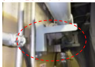
配管類サポート工事
