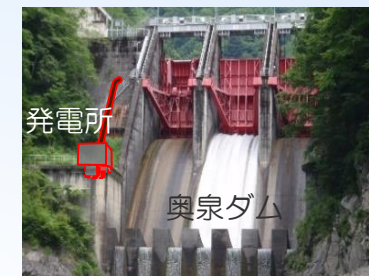
工事中の新奥泉水力発電所
