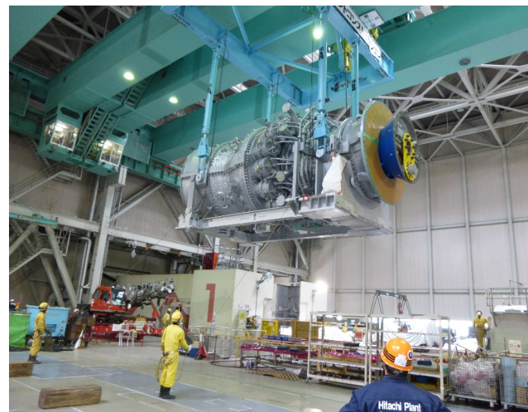
新型ガスタービンの据付
