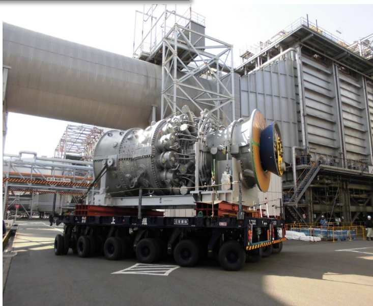
ガスタービンの発電所構内輸送
